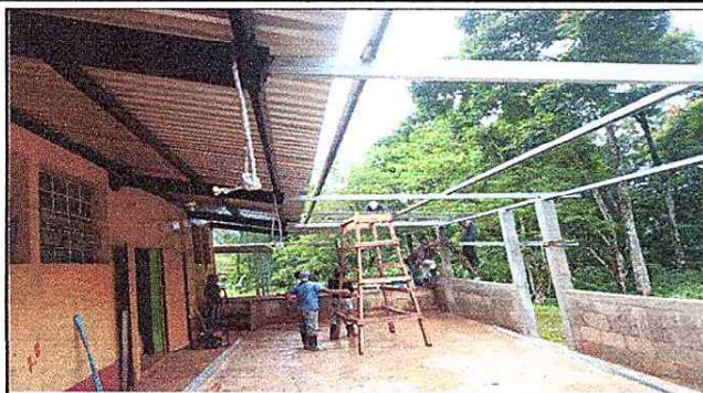
Foto1: Trabajo de estructrua metalica corredor de la escuela.
