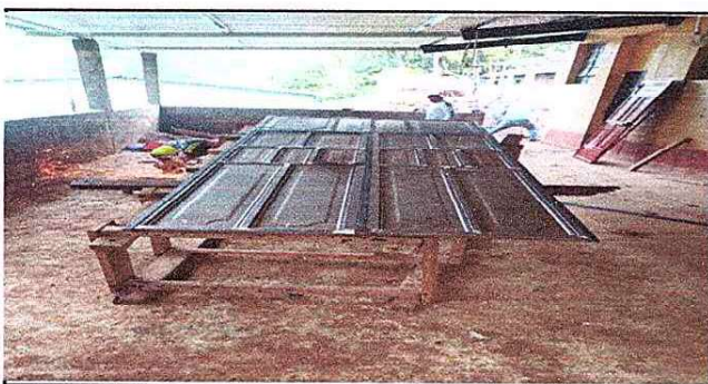
Foto 5: Trabajo de soldadura puerta.
