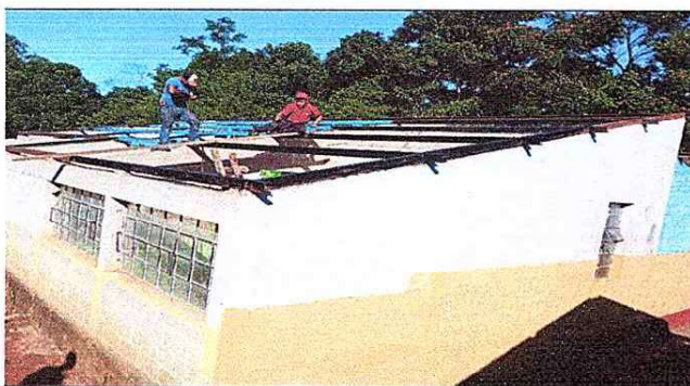
Foto 3: Trabajo de mantenimiento de estructura metalica.
