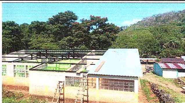
Foto 2: Trabajo de entechado.
