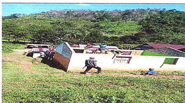
Foto 4: Trabajo de estructura metalica y cambio de lámina. Aula No. 2.
